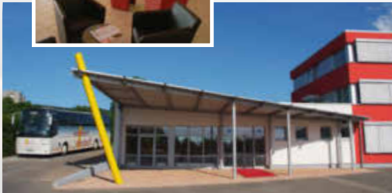
Unser modernes Kundenterminal am Betriebshof Northeim. Hier können Sie auch kostenlos und sicher Ihren PKW parken.
